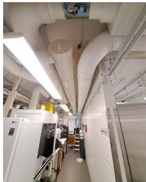
Tubulação ECTFE instalada no laboratório
