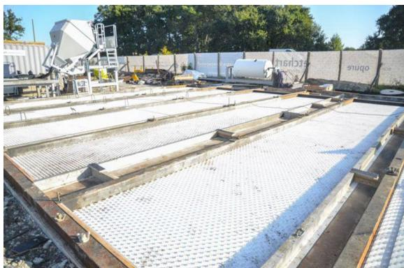
Para as paredes e tetos, a equipe de instalação utilizou peças de concreto pré-moldadas, revestidas com Sure Grip em PE.
