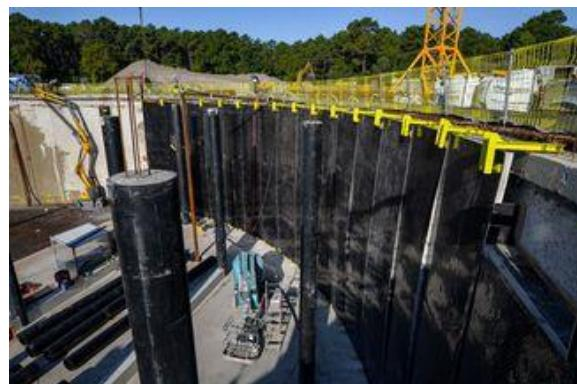
O revestimento Sure Grip em PE irá proteger o reservatório de águas residuais contra corrosão por décadas.
