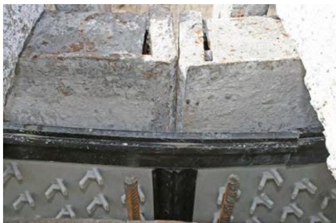
Montagem do Sure Grip® PE da Agru antes da concretagem. O revestimento fica apoiado em uma camada interna de concreto para dar estruturação durante a concretagem
