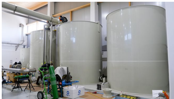
Para os numerosos tanques, foram instalados 4 toneladas de chapas PPH.
