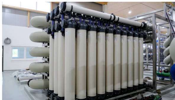
Nos filtros de membrana a água se abrande sem aditivos químicos.
