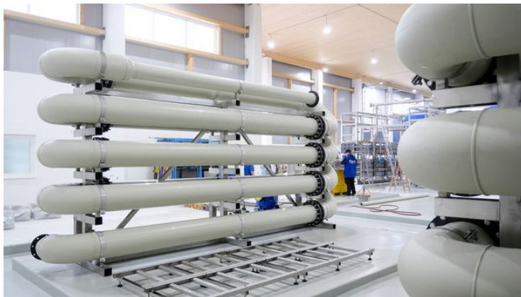
Foram instalados 200 metros lineares de tubos e acessórios PP AGRUCHEM no sistema de filtragem natural.
